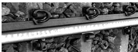
图1 钢轨波浪形磨损
